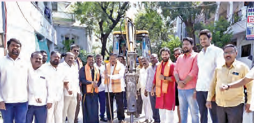
రోడ్డు నిర్మాణ పనులను ప్రారంభిస్తున్న ఎమ్మెల్యే మురా గోపాల్
